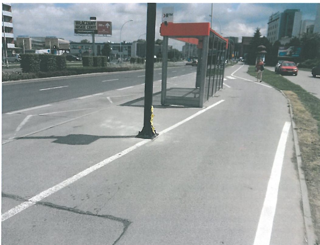
zdjęcie: 3 UL. Kopisto, tutaj linie trzeba poprawić, choć samo rozwiązanie nie jest bezpieczne
