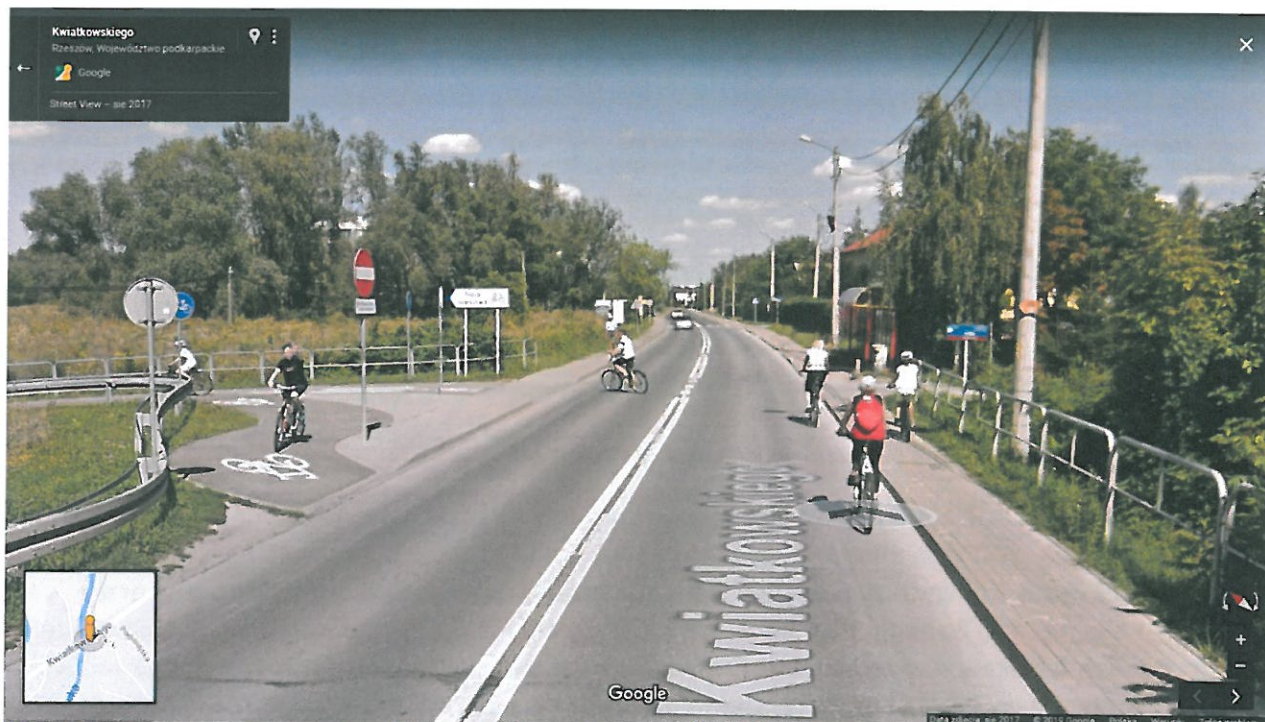
Rysunek 1 – Rzeszów ul. Kwiatkowskiego Wjazd i zjazd na drogi rowerowe brak służy
