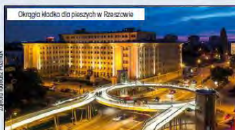
Okrągła kładka dla pieszych w Rzeszowie
