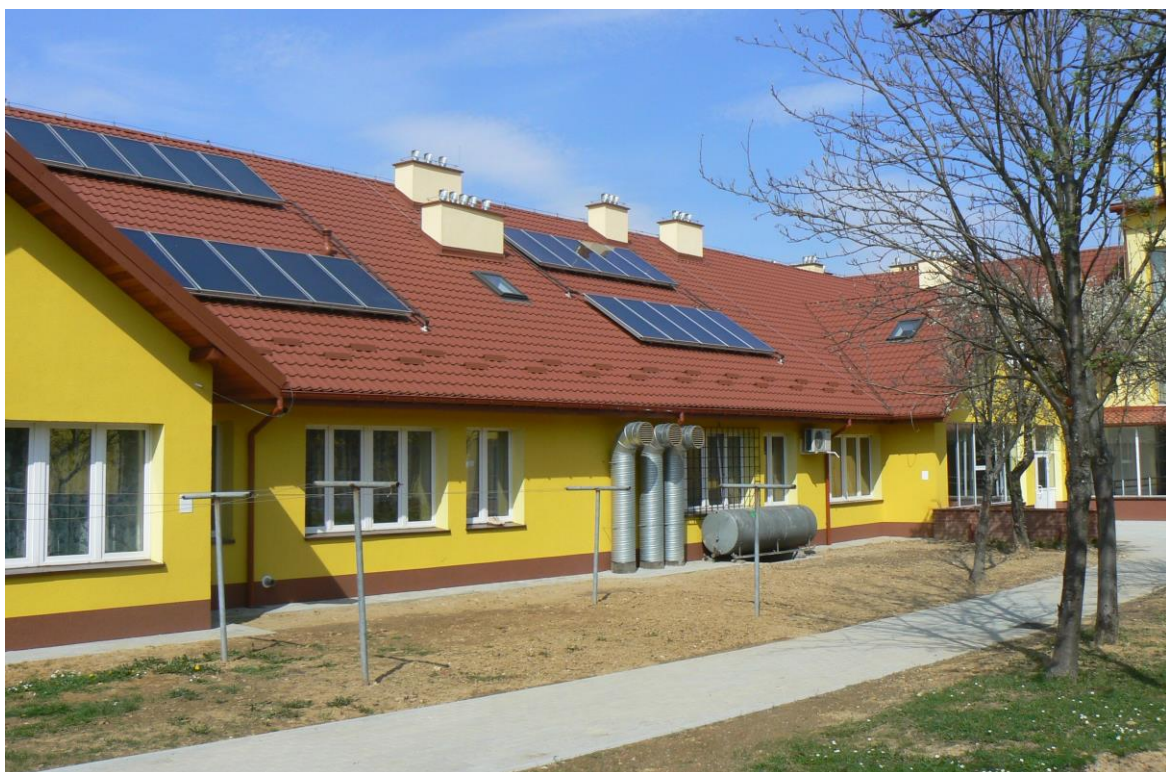
Zdjęcie nr 6. Modernizacja dachów z płaskich na spadziste nad całym kompleksem budynków DPS przy ul. Powstańców Śląskich 4, modernizacja elewacji zewnętrznej oraz wykonanie instalacji solarnej do podgrzewania wody (2011 – 2012 r.).
