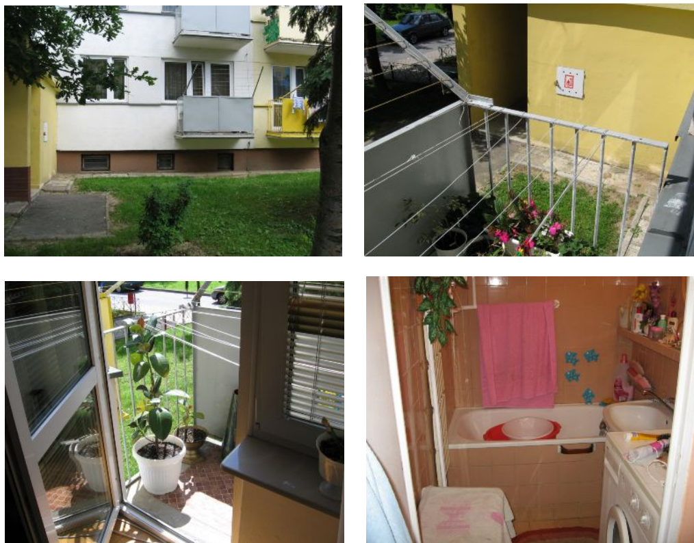
Zdjęcie 4. Mieszkanie przed likwidacją barier architektonicznych.
