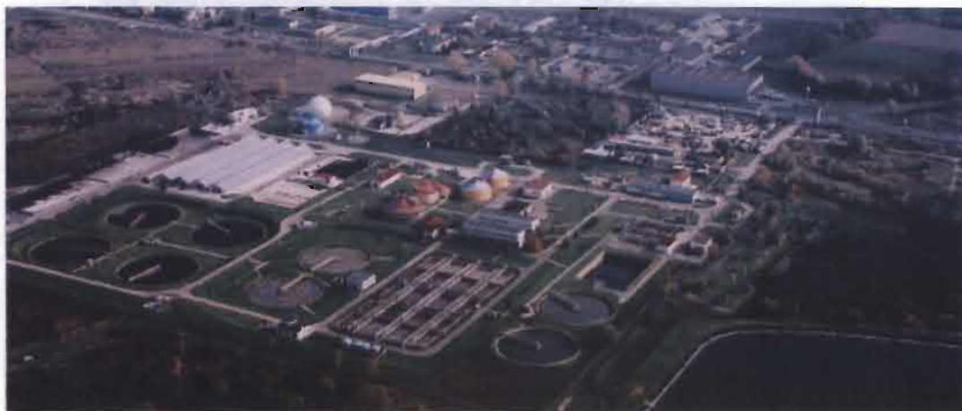
Fot. 6 Oczyszczalnia Ścieków dla miasta Rzeszowa 60
